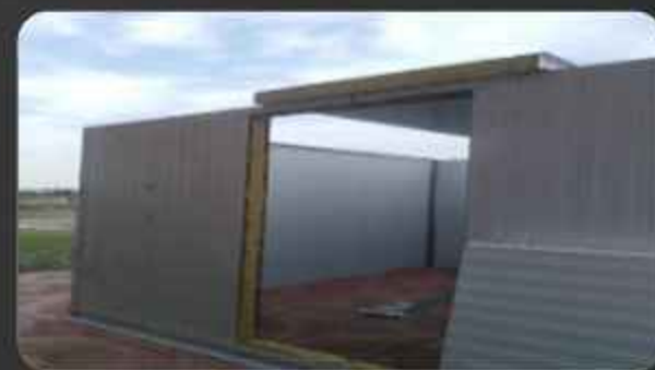
نظارت بر ساخت سردخانه سلف
