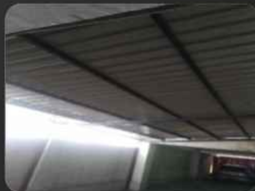
مسقف کردن حیاط خوابگاه مریم
