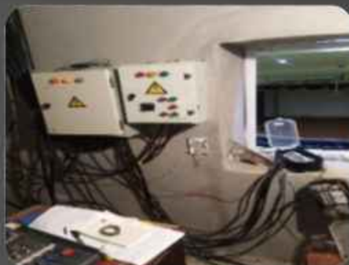
تعمیرات تأسیسات برقی تالار اندیشه و نصب تابلو برق
