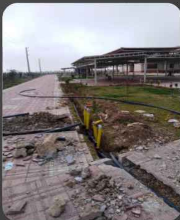
لوله کشی آب در محوطه دانشگاه جهت آبیاری فضای سبز
