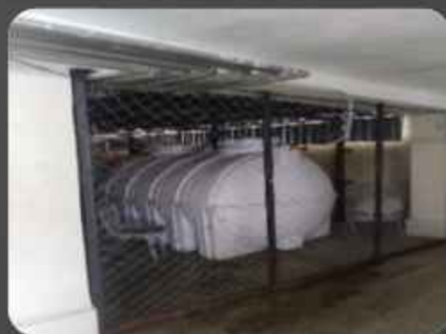
فتس زدن و تعمیر پمپ آب خوابگاه مریم
