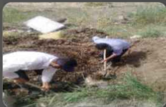
تعمیرات ترکیدگی لوله آب
